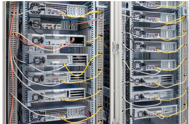
Jedes Rack ist über einen 100 Mbit Anschluss über Firewalls mit dem Internet verbunden. Es gibt redundante direkte Zugänge zu Internetaustauschknoten.
